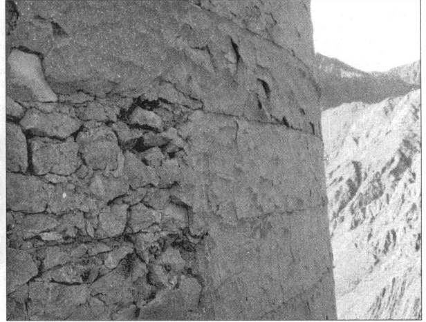
تصویر- ۲۰ برج چهل خانه - اندود بیرونی
